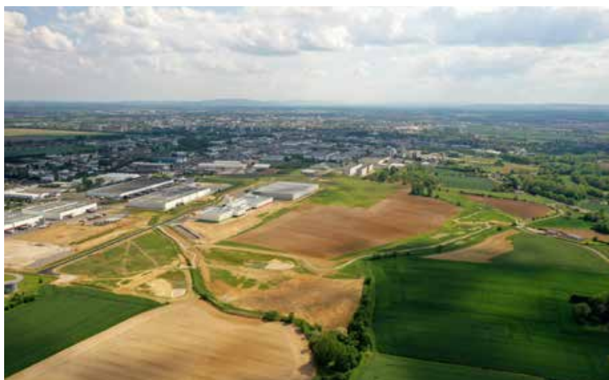
Vicky Foods construit une usine de production au cœur du site industriel clés en main SaôneOr, région Bourgogne-Franche-Comté. © Business France et Agence régionale AER BFC
